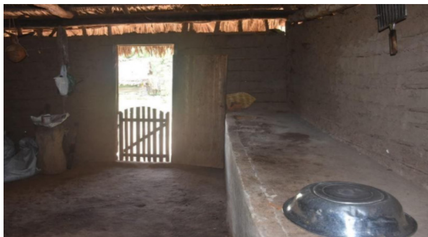
Figura 05: Forno de lenha feito com a base de tijolos de adobe, preenchido com barro e pedra e revestido com cimento – Comunidade Criolis/Boca da Mata, Território Saco das Almas, Brejo/Buriti- MA. Fonte: LATESE, 2021.
