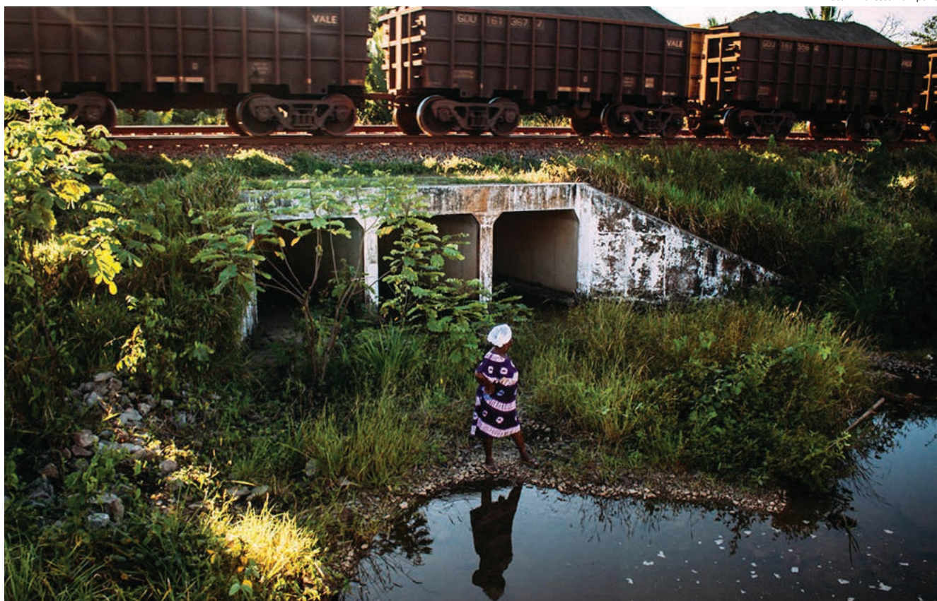
La empresa Vale creó un verdadero “corredor seco” para la construcción, ampliación y duplicación de la línea férrea en Maranhão
